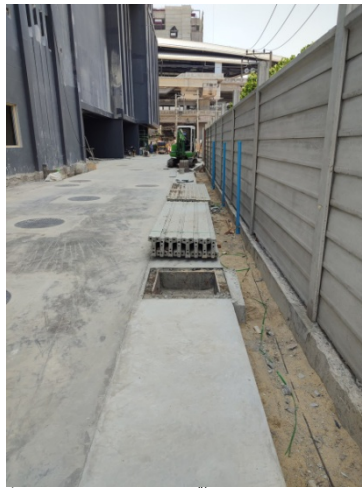
ภาพที่ 4-47 แนวท่อระบายน้ำและระบบบำบัดน้ำเสีย
