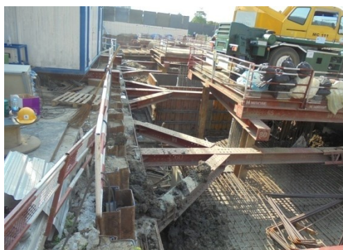
ภาพที่ 4-21 ทำระบบป้องกันดินพัง Sheet Pile
