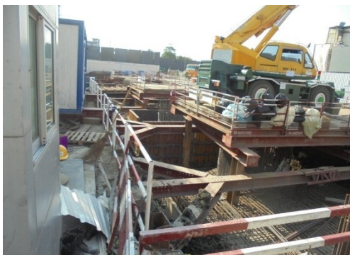
ภาพที่ 4-21 ทำระบบป้องกันดินพัง Sheet Pile
