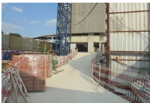
ภาพที่ 4-7 ปูแผ่นเหล็กหนาไว้เป็นทางวิ่งรถ และปัจจุบันเป็นพื้นคอนกรีตสำหรับให้รถวิ่ง
