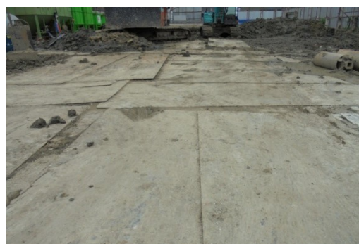
ภาพที่ 4-7 ปูแผ่นเหล็กหนาไว้เป็นทางวิ่งรถ และปัจจุบันเป็นพื้นคอนกรีตสำหรับให้รถวิ่ง
