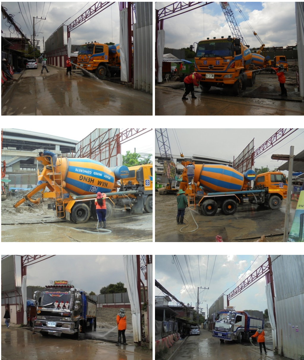
ภาพที่ 4-8 ล้างล้อรถบรรทุกด้วยสายฉีดแรงดันสูงก่อนออกจากโครงการ
