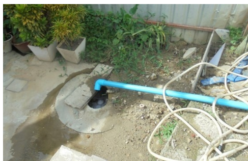
ภาพที่ 4-11 บ่อพักตะกอนภายในพื้นที่ก่อสร้าง
