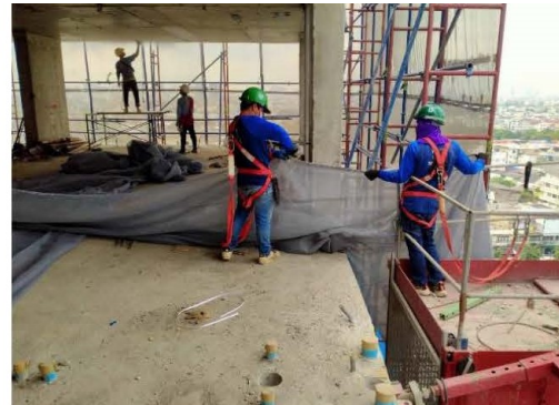
ภาพที่ 4-30 ติดตั้งนั่งร้านและสวมใส่อุปกรณ์ป้องกันภัยส่วนบุคคล
