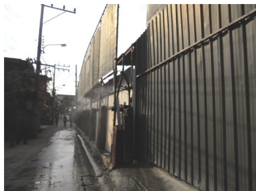
ภาพที่ 4-6 การก่อสร้างเสาเข็มแบบเจาะ โดยใช้แบบเจาะเปียกใช้สารเบนโทไนท์ และพ่นสเปรย์น้ำบริเวณริมรั้วโครงการ
