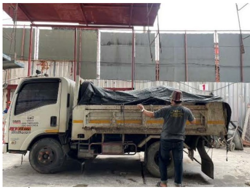
ภาพที่ 4-14 ปิดคลุมท้ายบรรทุกทุกดินก่อนออกจากโครงการ
