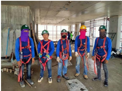
ภาพที่ 4-30 ติดตั้งนั่งร้านและสวมใส่อุปกรณ์ป้องกันภัยส่วนบุคคล
